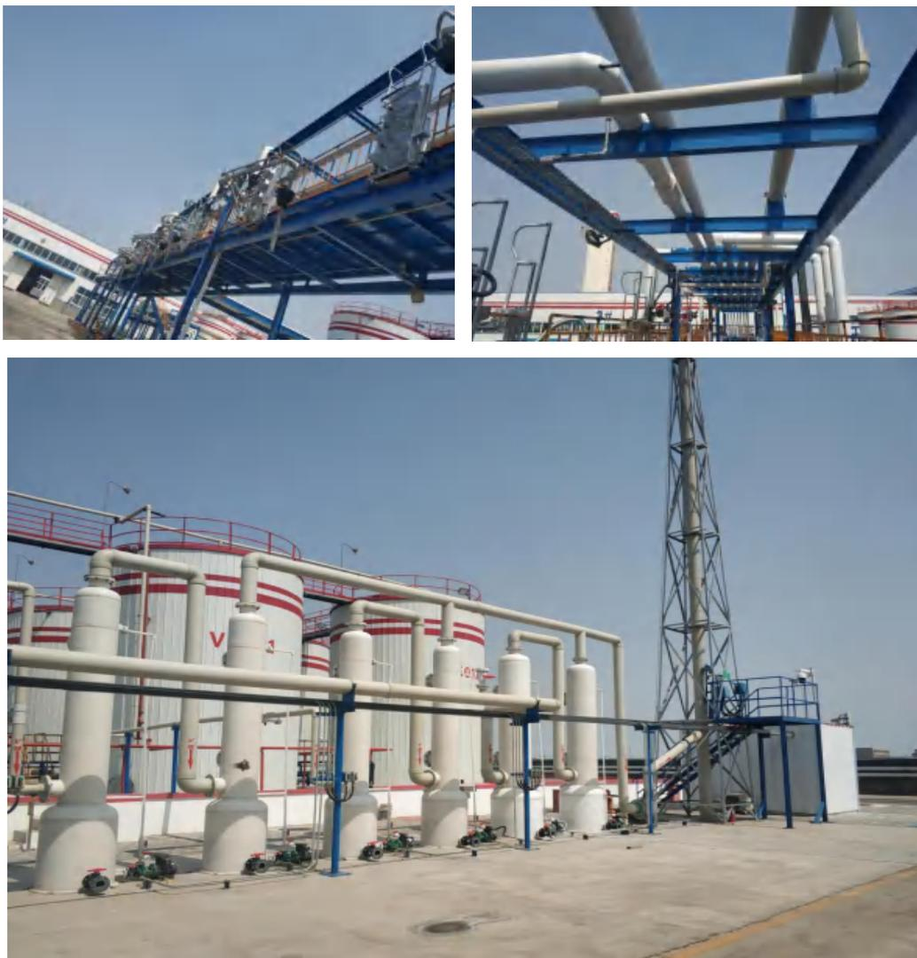
图 4.2-12 TA009、TA010、TA011 废气处理措施建设情况
