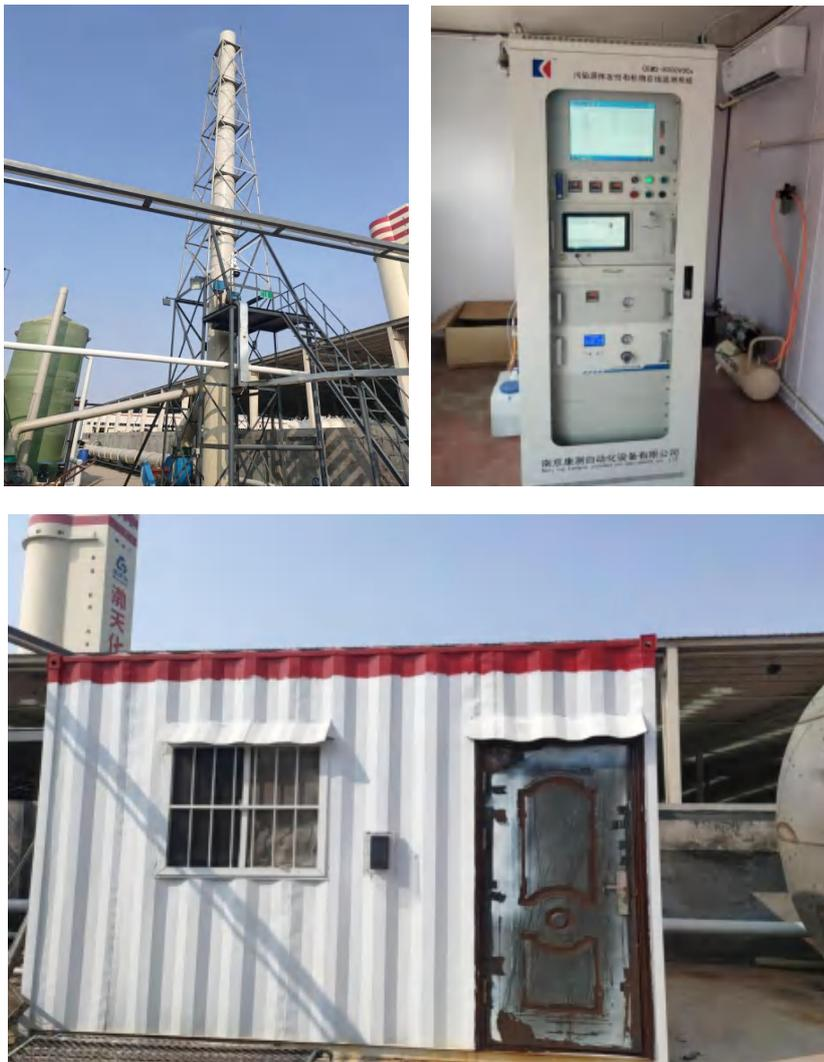
图 4.3-3 1#废气措施采样平台、排气筒、在线监测
