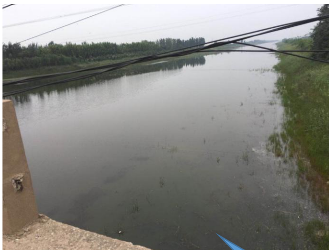
顶管穿越河流
